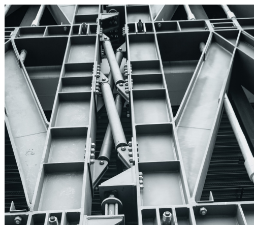
(D) COMPLEX STRUCTURAL STEEL SOLUTIONS
